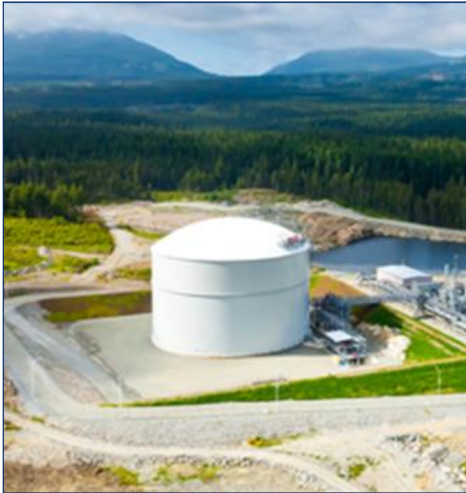
FortisBC Mt. Hayes LNG Production Plant
